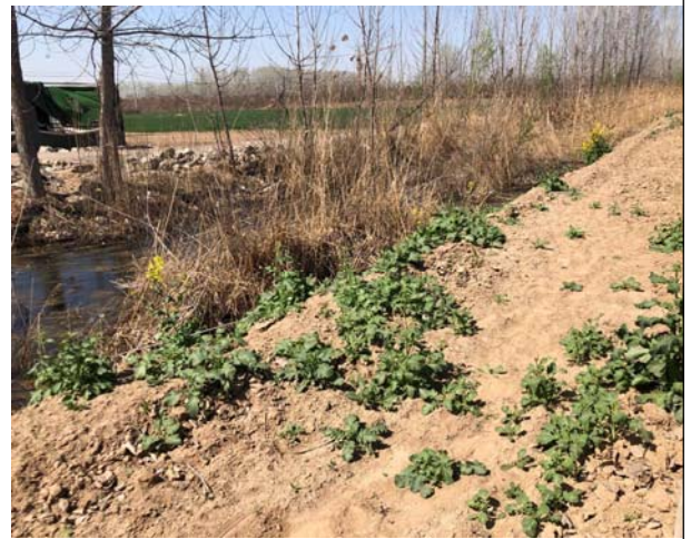
给排水管道（顶管）
