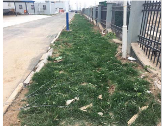
厂区撒播草籽
