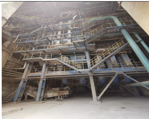
垃圾焚烧主厂房
