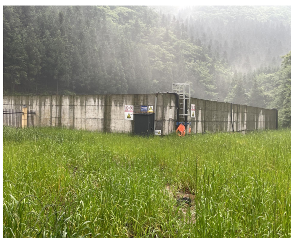
后期雨水收集池
