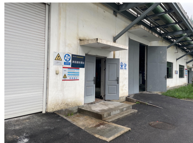
渗滤液处理站
